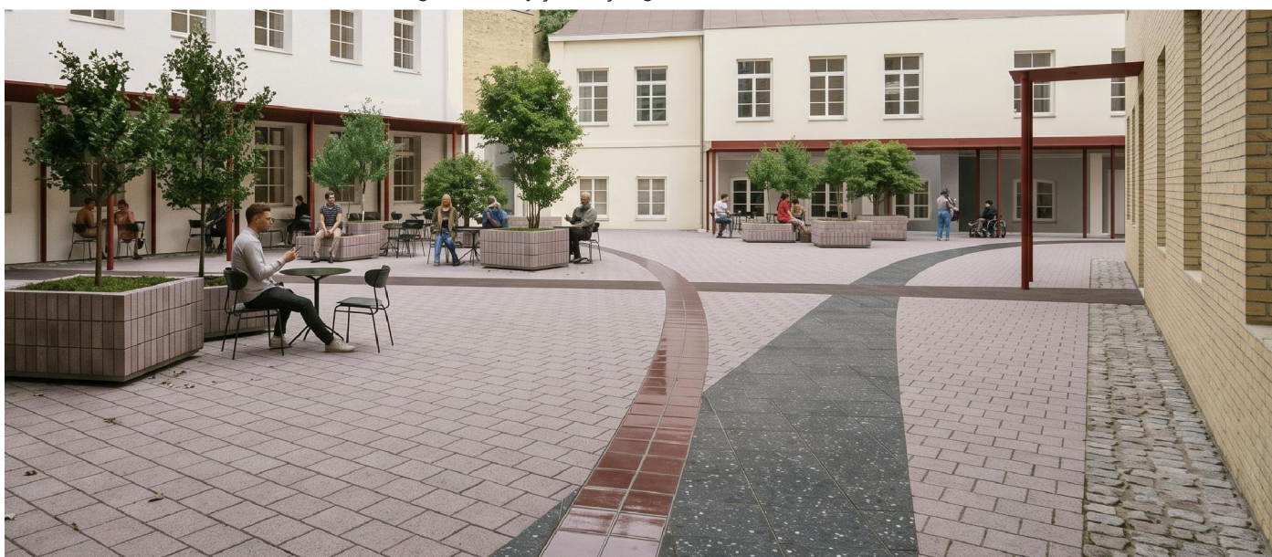
Sutvarkius kiemo dangų aukščius senos trinkelės pernaudojamos, papildomai panaudojamos iš vidaus išmontuotos terrazzo plytelės, keraminės raudonos glazūros plytelės ir tamsiai rudos plytelės.
